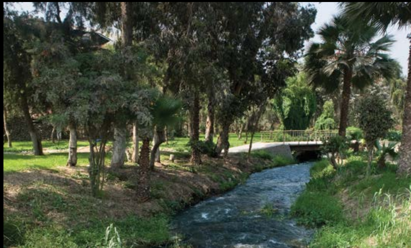
› Infraestructura en la bocatoma del canal Surco.
