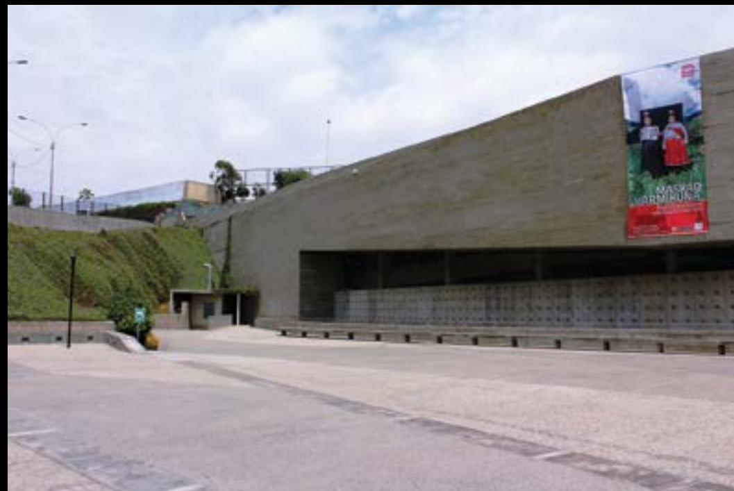
^ LUM (Lugar de la Memoria), en avenida Del Ejército. Un ramal del canal Surco desembocaba donde ahora se levanta el edificio.
